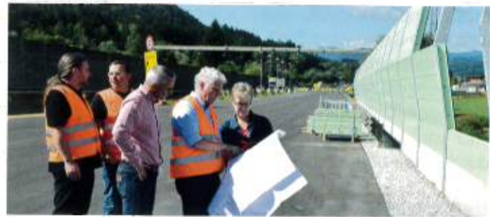
Bürgermeisterin informiert sich über den Baufortschritt
