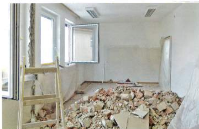
Während der Umbauarbeiten
